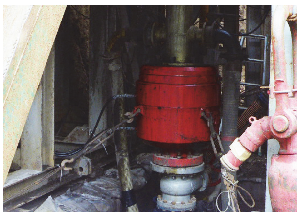
アニュラータイプ BOP 設置状況
