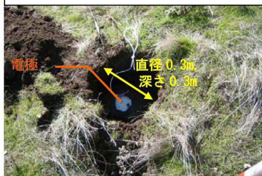
埋設前の状況
