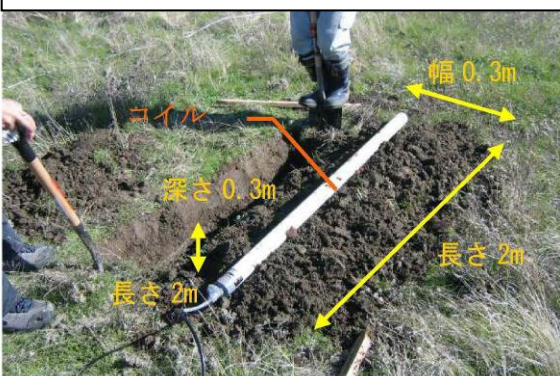
コイルの埋設状況
