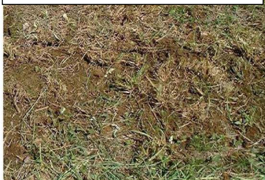
コイル埋設場所の埋め戻し後
