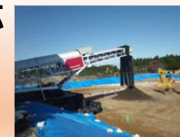
中間貯蔵施設 土壌貯蔵施設
