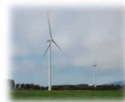
風力発電 (環境省HPより)
