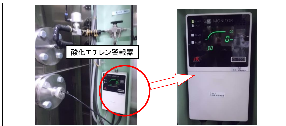
図 13 酸化エチレン警報機の設置例
