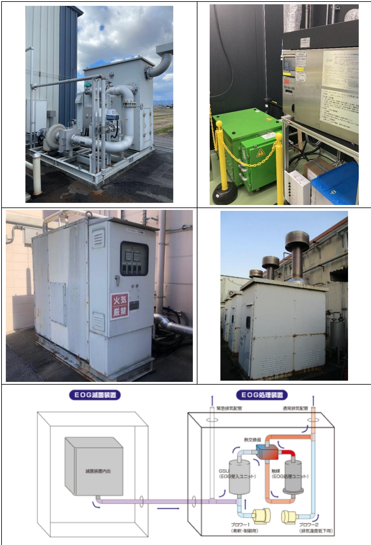
図 12 排ガス処理装置の設置例(触媒燃焼)
