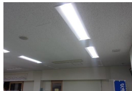
※事務所の照明が点灯、避難者の受入れが可能に
