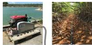
遠隔操作によるかん水ポンプの起動
