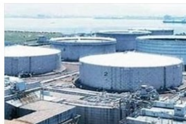
石油貯蔵タンク
