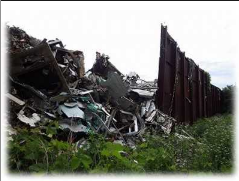
崩落した金属スクラップ
