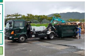
写真：仮置場からの搬出状況
