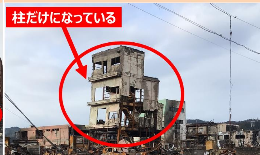
㊦ 建物の壁がなくなり柱だけになっている
