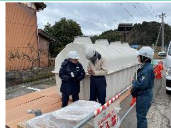
能登町での浄化槽の状況確認
