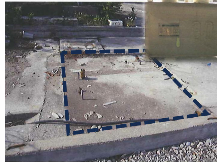
撤去されたキュービクルの基礎部分
