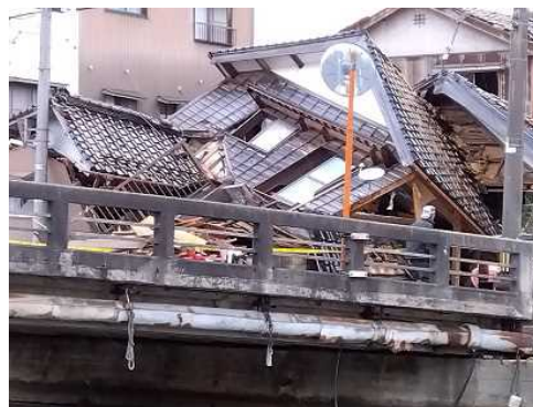
石川県穴水町 民家の被害 （1月5日）
