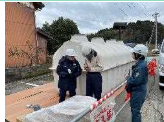
能登町での浄化槽の状況確認
