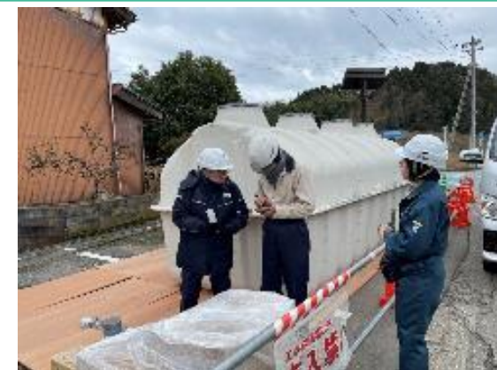
能登町での浄化槽の状況確認
