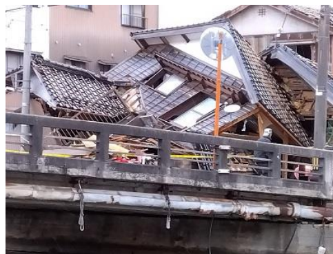
石川県穴水町 民家の被害 （1月5日）
