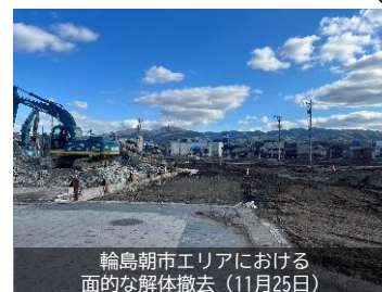
輪島朝市エリアにおける面的な解体撤去 (11月25日)
