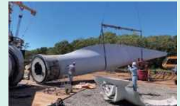
例：風力発電のブレードの解体
