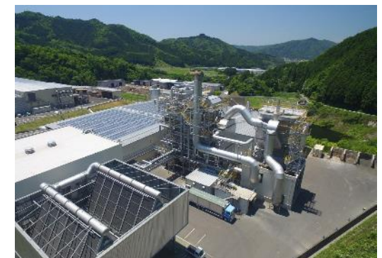
木質バイオマス発電施設の外観
