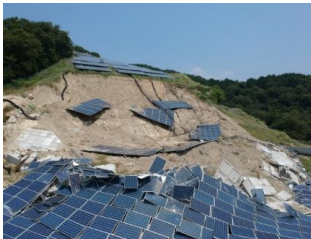
土砂崩れで生じた崩落
