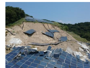
土砂崩れで生じた崩落
