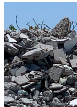
図 災害時のコンクリート殻 国環研撮影
