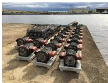
事業②：貝殻基質ユニットを用いた 生物生息の場の創出
