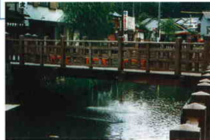
古い街並のなかにある樋橋
