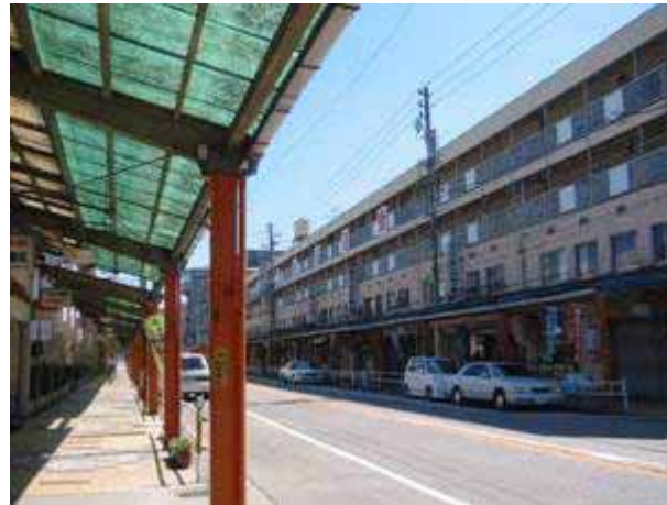
愛知県刈谷市(商圏人口28万人)の中心街
