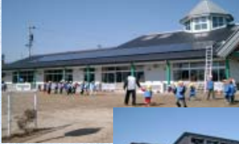
鼎みつば保育園に設置された太陽光発電設備
