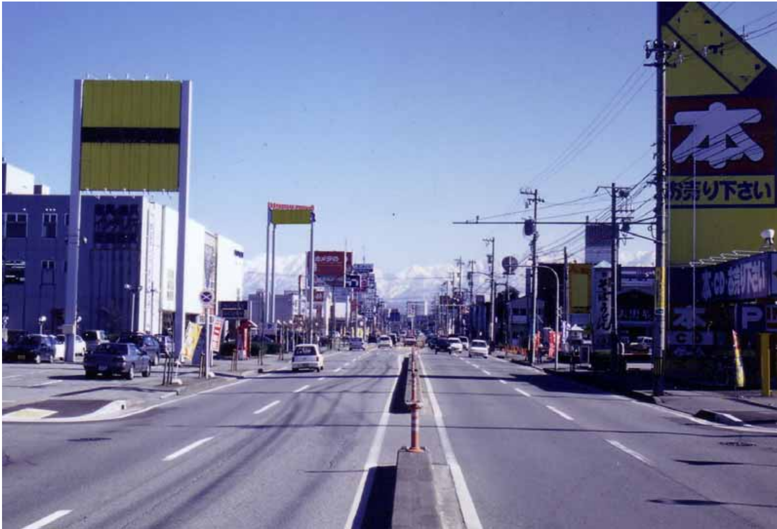
主要地方道富山環状線(都市計画道路草島西線) 写真:富山県都市計画課提供
