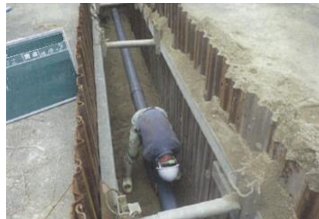
下水道管渠の布設（整備）状況
