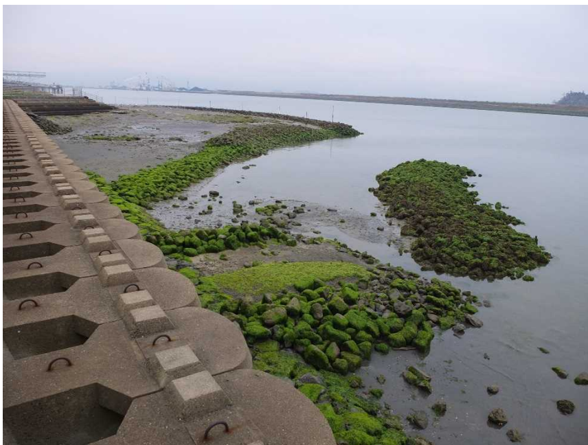
図 3.7.6 八代港周辺での「なぎさ線の回復」現地実証試験
