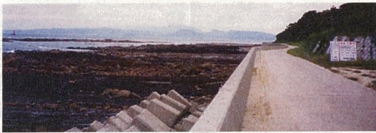
道路護岸（写真上：帯北町海岸； 写真下：五和町通詞島海岸）
