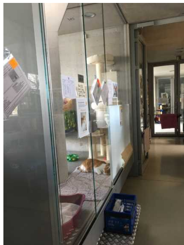
犬、猫ともに設計に不具合があり、模倣には適さないとのアドバイスがあった。猫舎はガラス張りで、猫が身を隠す場所がない。部屋の仕切りに隙間があるため温度管理や、感染症対策に支障が生じるなど。1室ごとに清掃用具を分け、キャットタワーやハウスを入れ目隠しを設けるなどして対応。(ベルリン)
