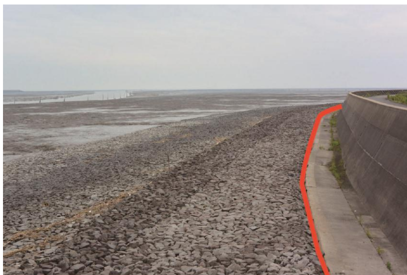
海岸防波堤（法尻）境界
