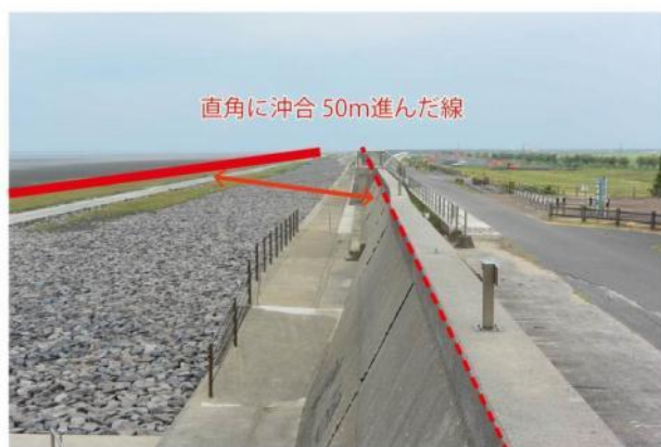
写真 堤防表護岸天端肩から 50m 沖合線
