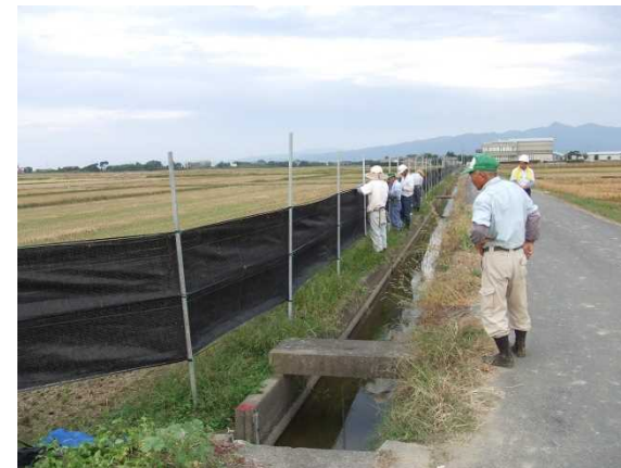
防鳥ネットの設置
