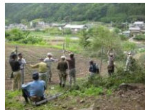
侵入防止柵の設置
