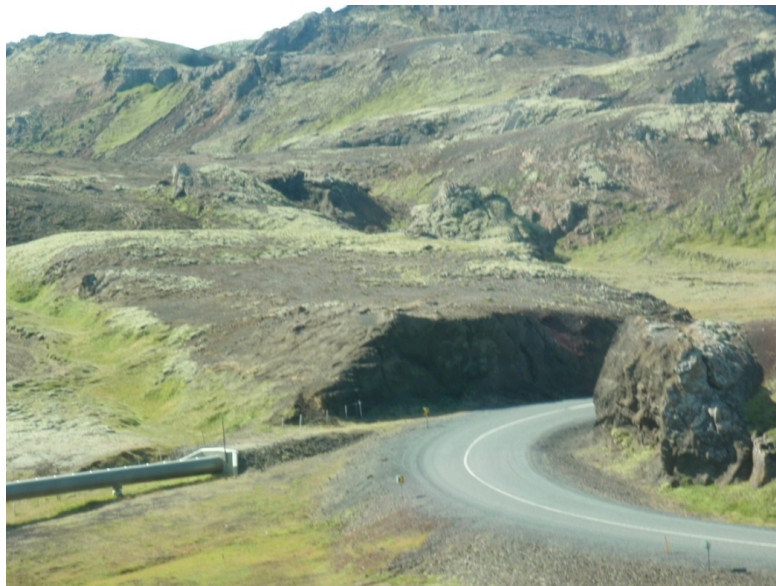
景観の重視されるエリアで配管の地下埋設を行った事例（アイスランド）
