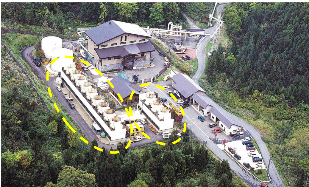
写真出典：東北電力(株)パンフレット
