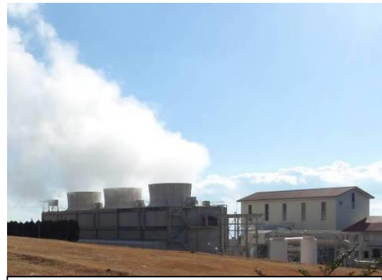
冷却塔から立ち上る水蒸気
