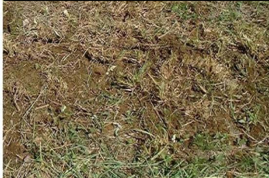
コイル埋設場所の埋め戻し後
