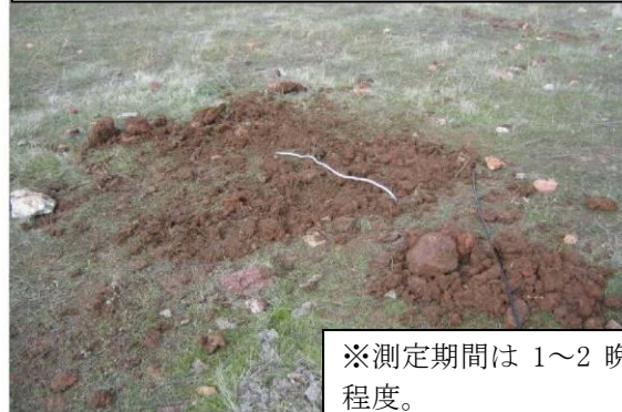
埋設後の状況
