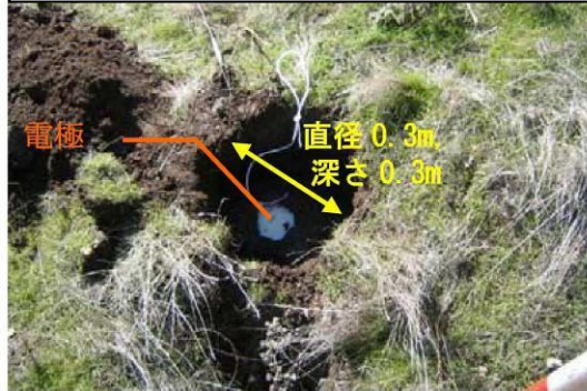
埋設前の状況
