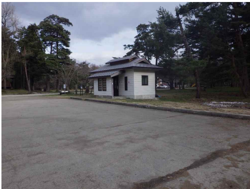
公衆便所と駐車場（猪苗代町）
