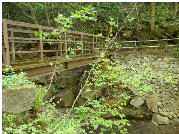
沢に架かる橋
