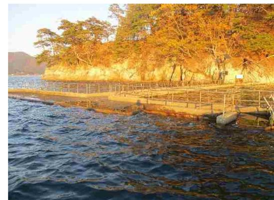
大島（オランダ島）にある唯一の船着き場で、海水浴等のオランダ島の利用者に乗せた船が発着する。東日本大震災による津波で破損しており、今後、山田町において復旧・再整備を行う予定。既存施設の規模（120㎡）を基本とするが、設計の詳細が未定であるため、余裕を見て180㎡としている。
