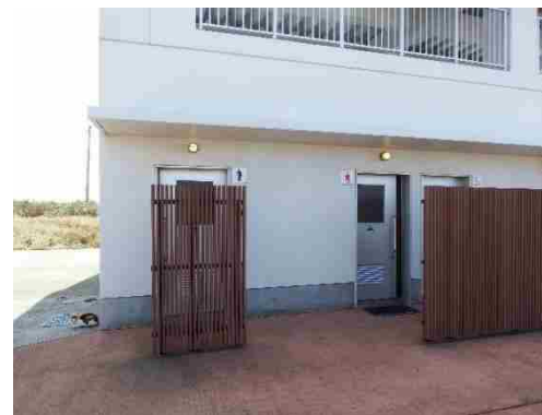
トイレ(伊仙町)
