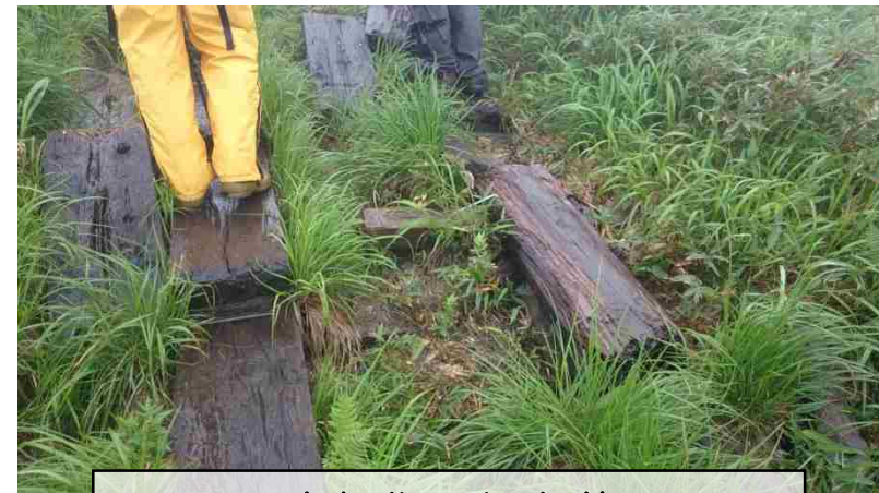
老朽化した木道 (雨で濡れると非常に滑りやすい)
