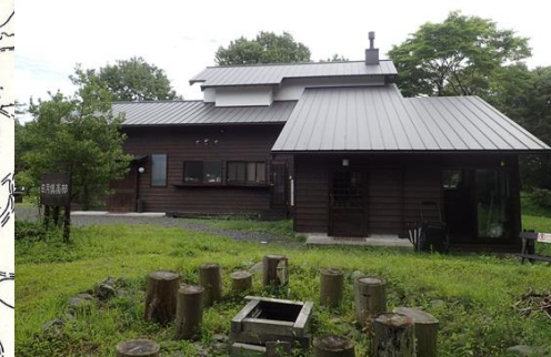
既存簡易宿泊棟
