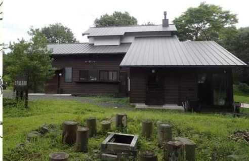
既存簡易宿泊棟
