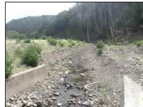
＜河川＞ 礫が堆積し、場所により伏 流して瀬切れしている
