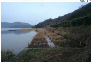
かご枠及び覆土や石積護岸による自然再生護岸への転換
