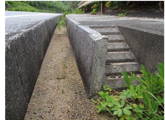
小動物用スロープ付き側溝
