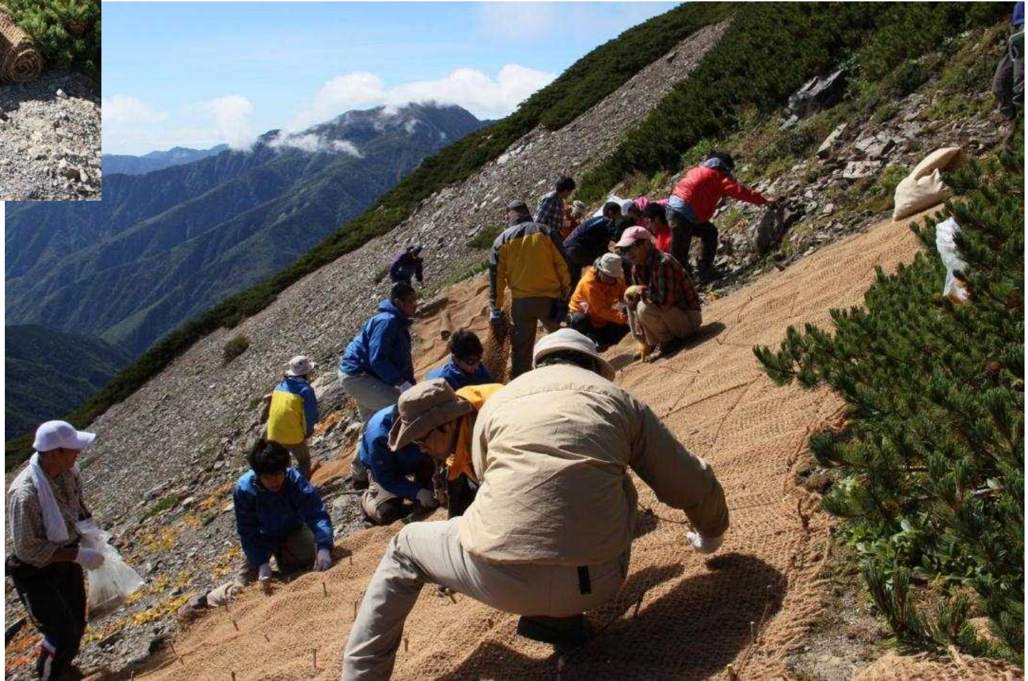
塩見岳(長野県) マットを敷設し土壌流出を防止
