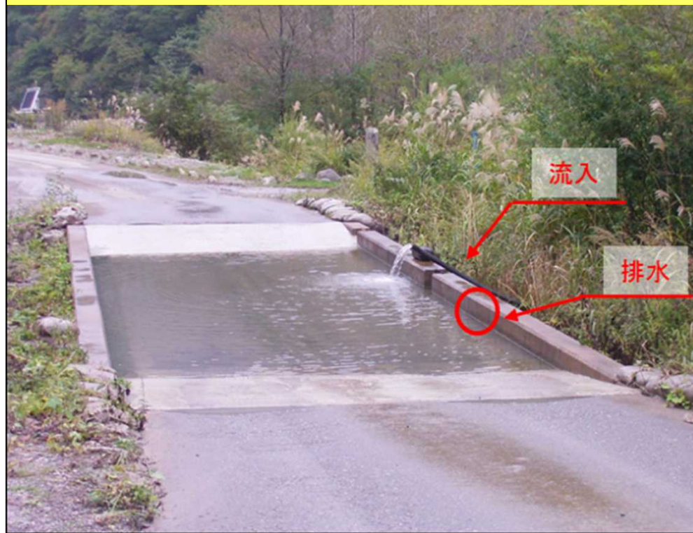
工事車両のタイヤの洗浄
