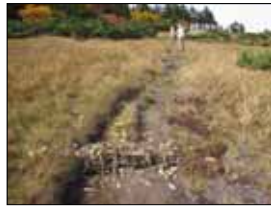
粗朶を利用した 土砂流出防止柵
