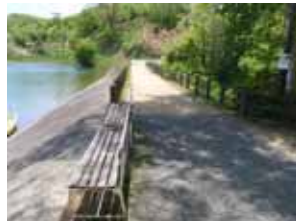
既設の 歩道 (東北自然歩道)
