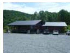
既存の管理棟
