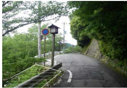
車道の拡幅箇所
