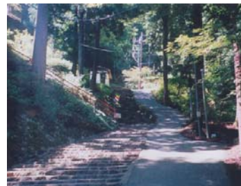
公衆便所予定地
