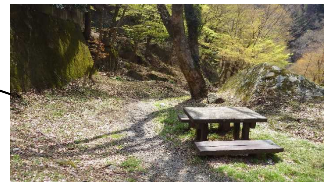
敷砂利施工区域の様子②
