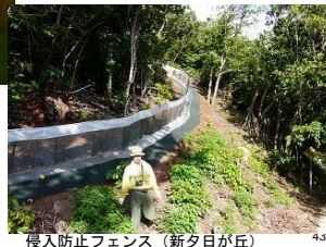
侵入防止フェンス (新夕日が丘)
